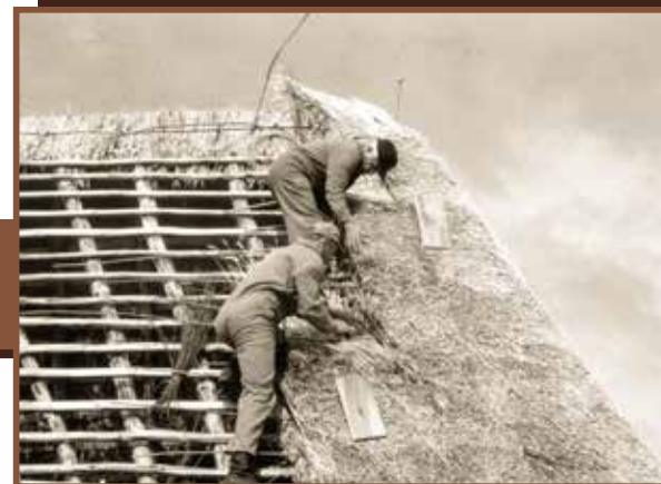
Herstellung eines erhöhten Strohdach auf dem Haus in Felsőszölnök Bild von: Endre Nagy (2000)
