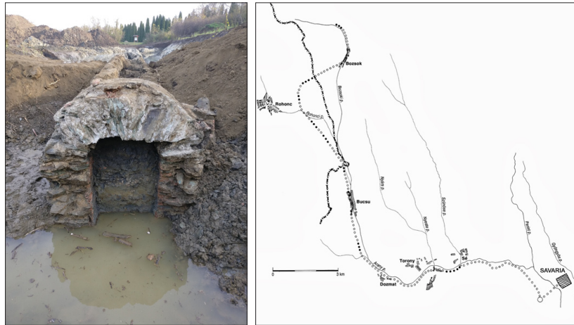
Römisches Aquädukt an der Grenze zu Savaria, die Spur des römischen Aquädukts Foto: Krisztián Anderkó, Ferenc Derdák
